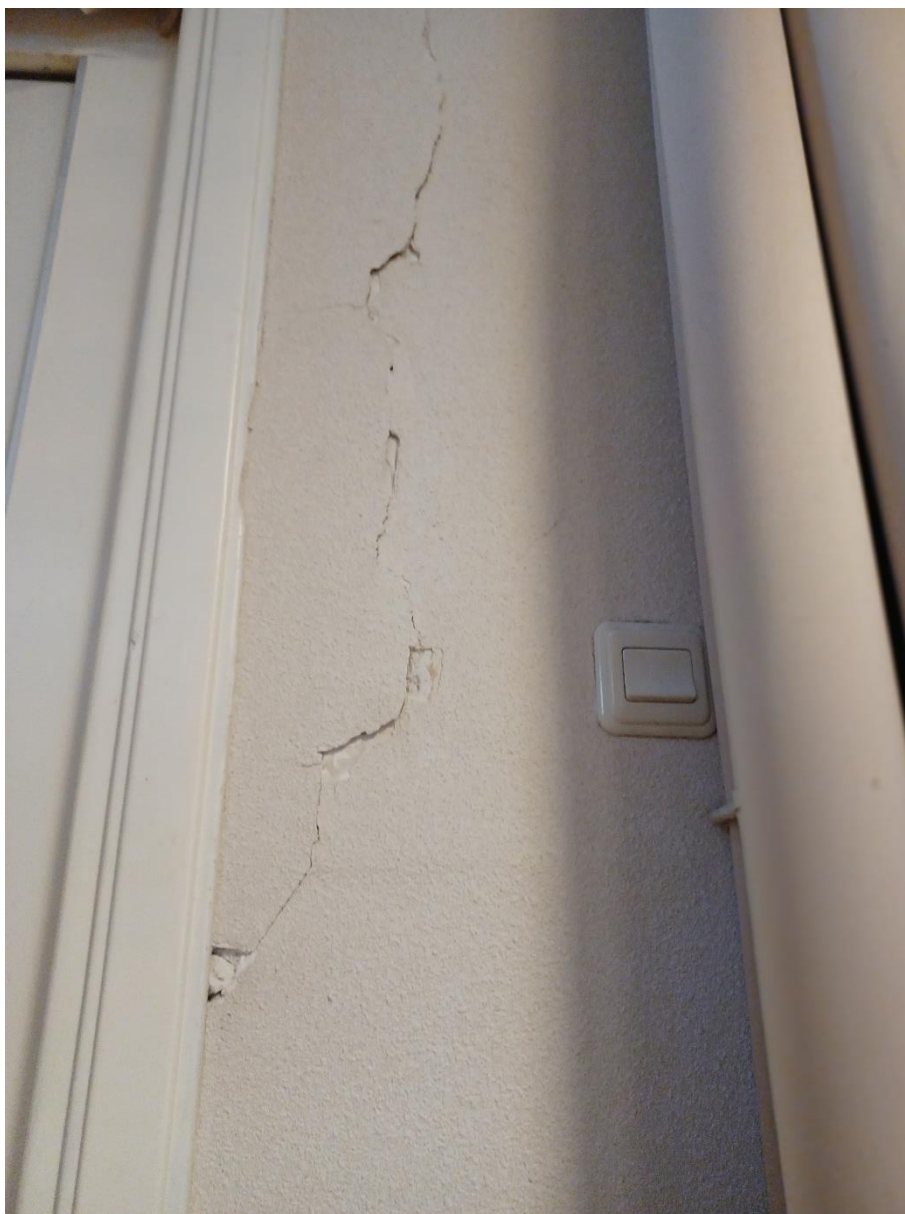
Foto 4 Scheurvorming
